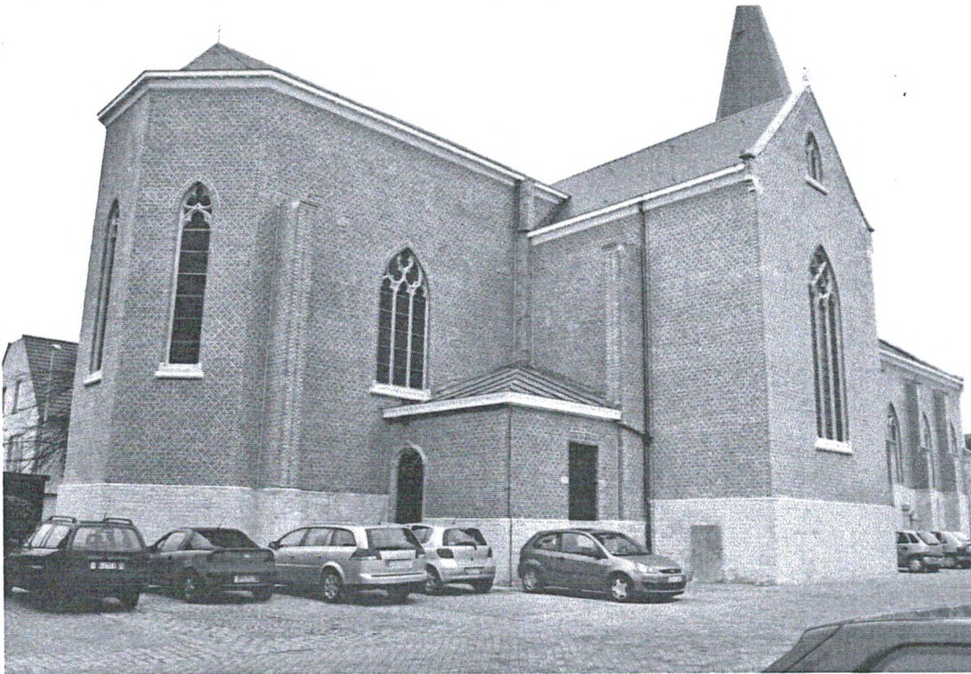
Koor, sacristie en zijbeuk van de Sint-Hubertuskerk na de renovatie. (februari 2009).
